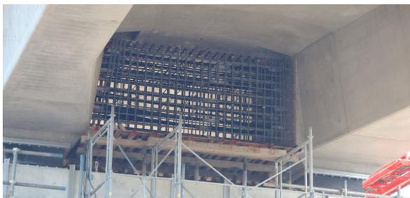
写真 2(3) 中間支点横桁配筋状況
