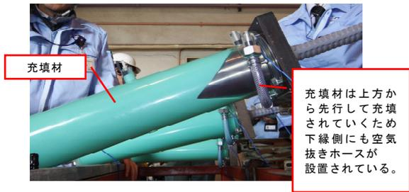
写真 4(1) グラウト充填確認状況
