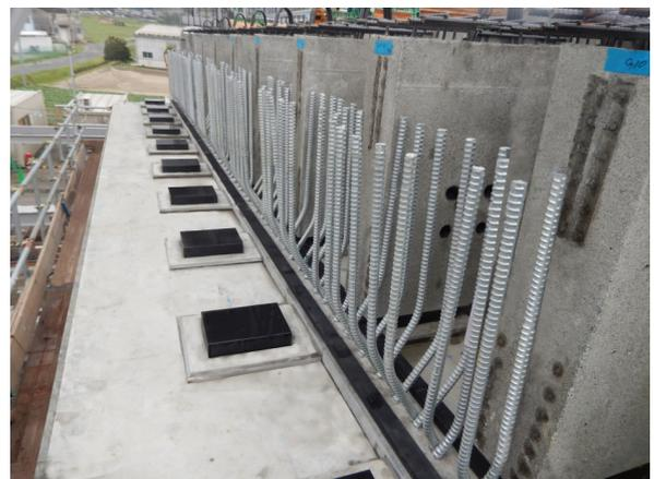
写真 5 連結部メナーゼヒンジ鉄筋
