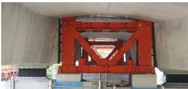
写真 2(1) 支持台撤去前の支点横桁部
