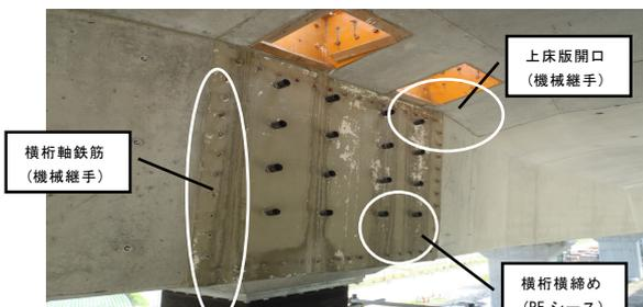
写真 2(2) 支持台撤去直後の支点横桁部
