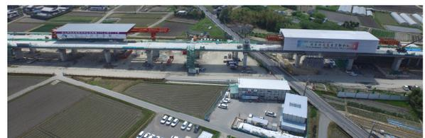
写真 10(1) 移動支保工施工状況
