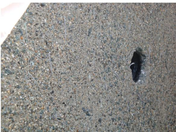
写真 9(2) バルチップ MK (主桁製作後)
