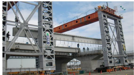
写真 10(2) プレテン T 桁橋 (門型クレーン架設) 施工状況
