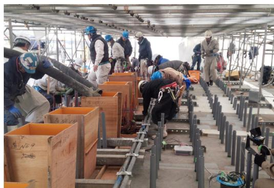
写真6 上床版部へのコンクリート充填状況
