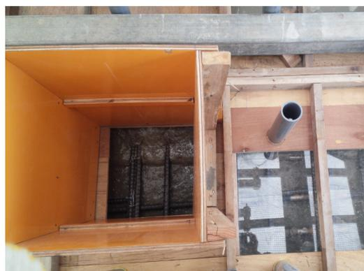
写真8 透明型枠による充填状況の見える化
