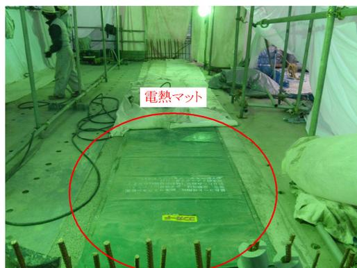
写真9 温度ひび割れ対策用の温度調整設備
