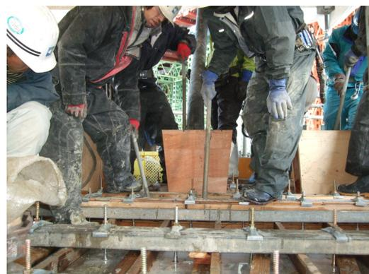
写真7 コンクリートの突き押し作業例
