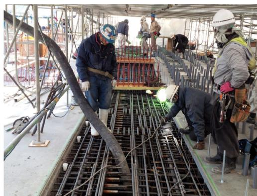
写真5 高流動コンクリートの打込み状況
