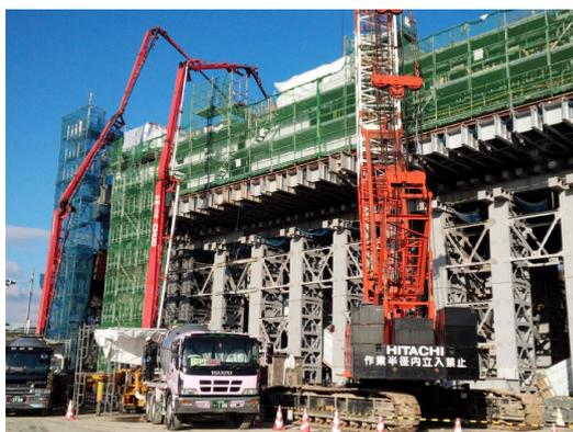
写真4 高流動コンクリートの圧送状況
