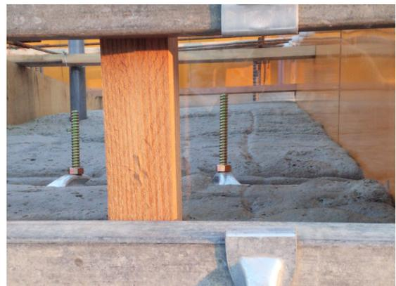
写真2 打上り面に発生した気泡層
