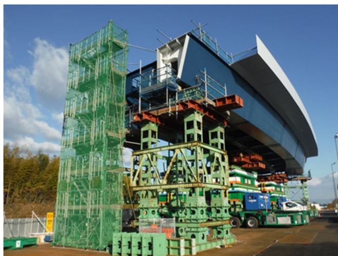
図3 鋼桁地組立ヤード状況
