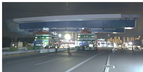
図5 多軸移動台車による鋼桁運搬状況
