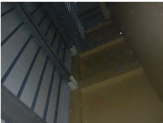
立体倉庫 吹抜け全景写真
