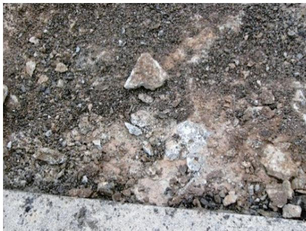
写真2 コンクリートの土砂化（国道158号）
