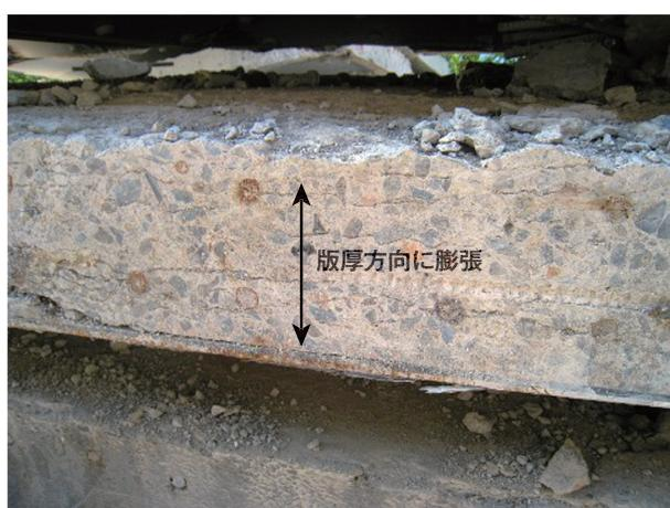
写真3 RC床版及びコアの水平方向ひび割れ（左：RC床版、右：コア）
