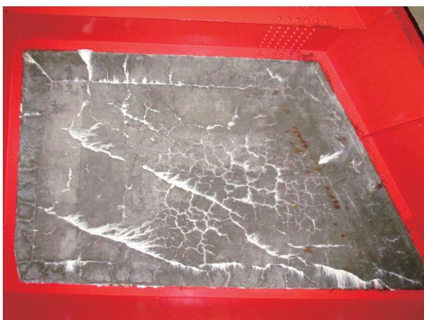
写真1 RC床版の劣化状況（国道157号）
