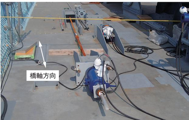
写真8 橋軸方向間隔調整設備
