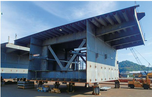
写真1 1部材の仮組立状況
