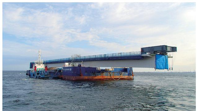
写真6 大ブロック部材の曳航状況
