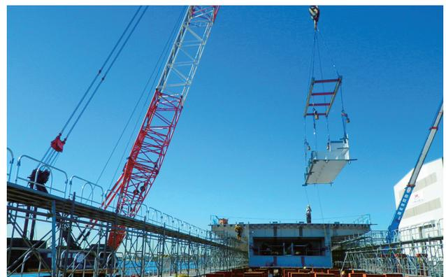
写真4 地組立ヤードにおける断面部材の地組立
