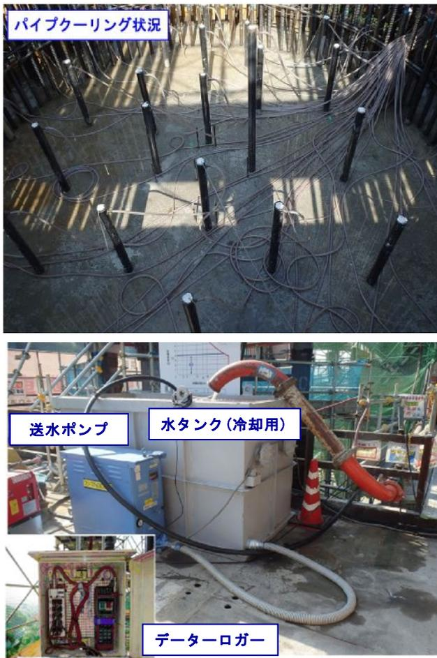
写真5 PD2橋脚のパイプクーリング状況と装置
