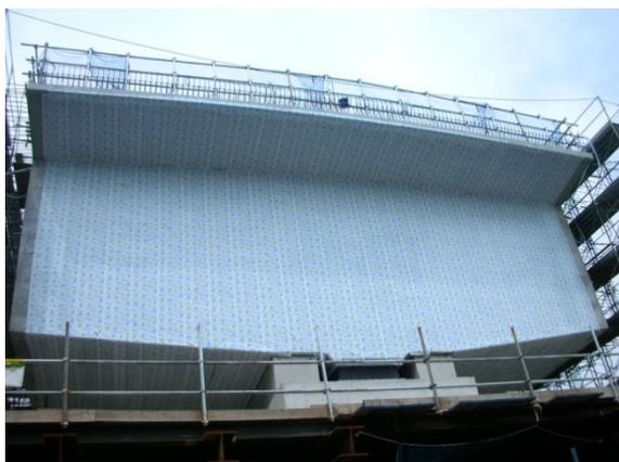
写真 9 側枠面・底枠面 保水養生テープ
