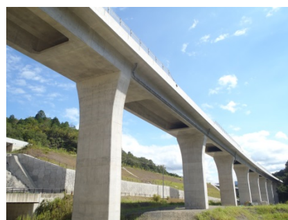
写真 17 本橋施工状況写真
