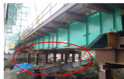
写真 16 高さ調整材設置
