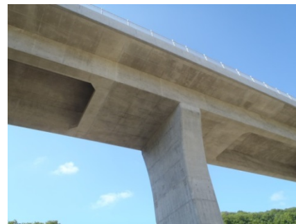
写真8 柱頭部付近箱桁側面
