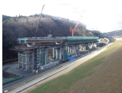
写真6 箱桁断面支保工施工状況
