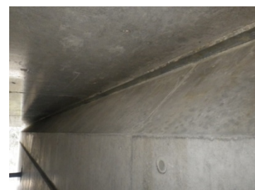
写真 11 延長床版底板先端形状 ハンチ部拡大（見直し提案後）
