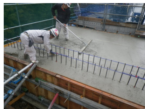
写真 14 底板天端仕上げ状況
