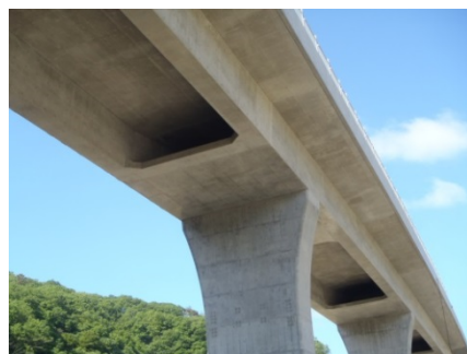
写真7 柱頭部付近箱桁断面
