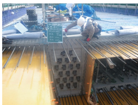
写真3 箱桁断面出来形
