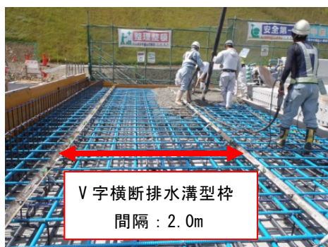
写真 12 底板 V 字排水溝設置
