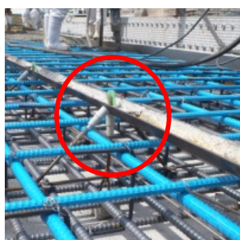
写真 13 V 字排水溝固定状況
