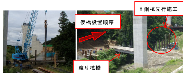
写真 15 仮橋 H 鋼杭先行打設状況
