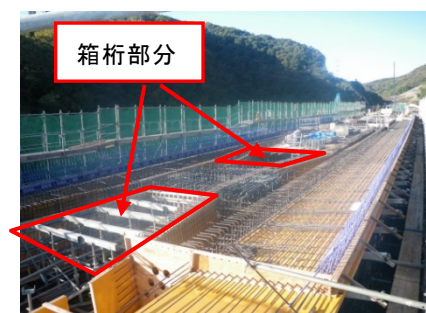
写真2 主桁鉄筋型枠組立状況
