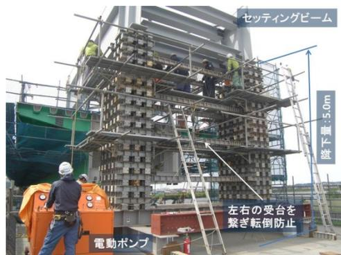
写真4 降下作業状況 (P3 桁上)
