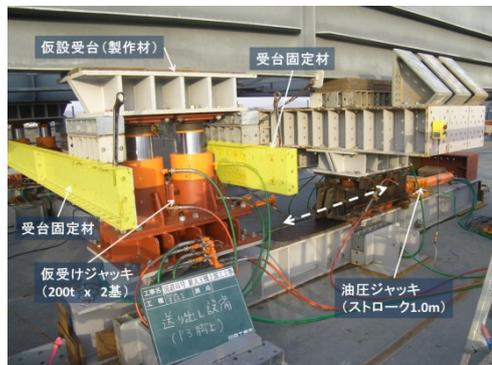
写真3 送出し設備 (P3 桁上)
