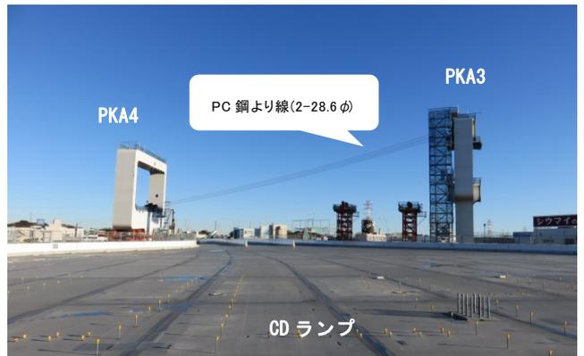
写真 1 鋼製脚のキャンバー調整状況
