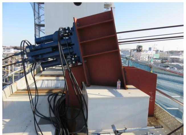
写真 2 ダブルツインジャッキを使用した引き込み装置 (ジャッキ能力=片側 1500kN)
