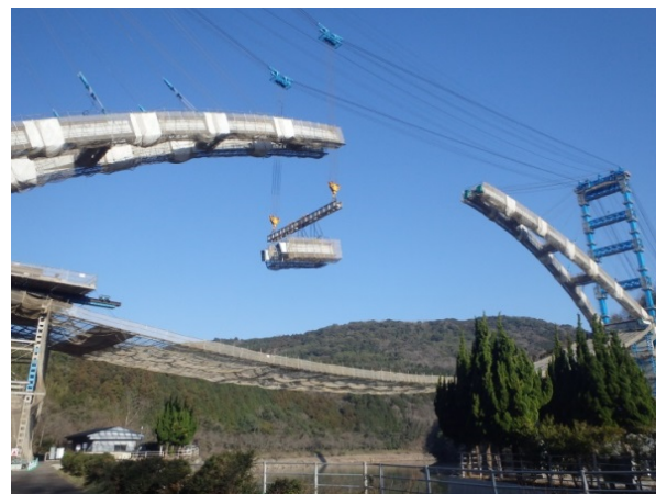
アーチの架設状況
