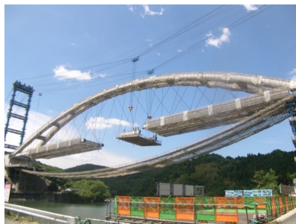
補剛桁の架設状況
