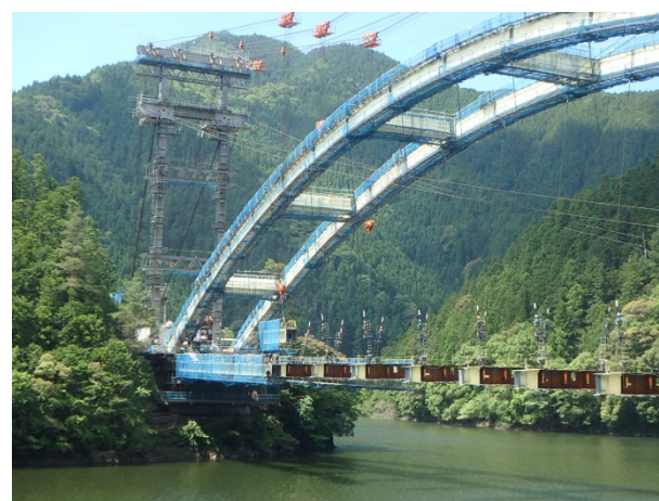
補剛桁架設状況
