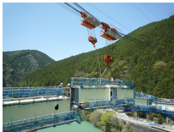
アーチリブ閉合状況
