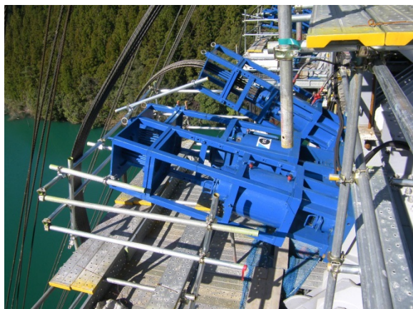
塔頂梁側の VSL ジャッキ
