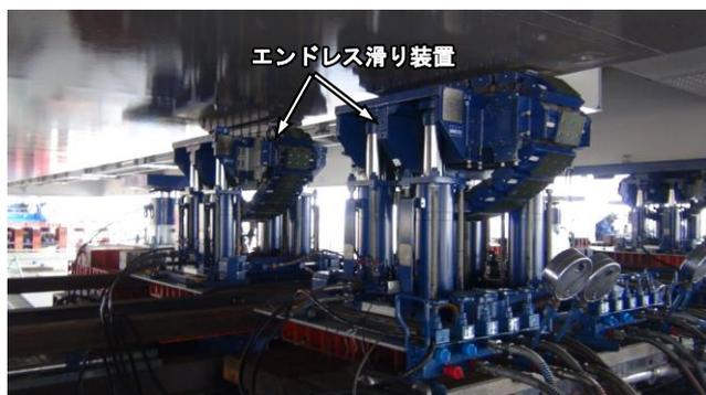
写真2 エンドレス滑り装置の縦列配置
