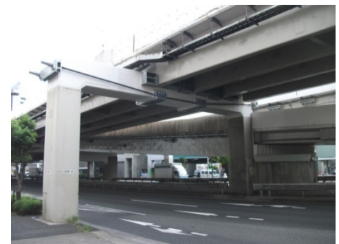
写真 6 外ケーブル取替完了
