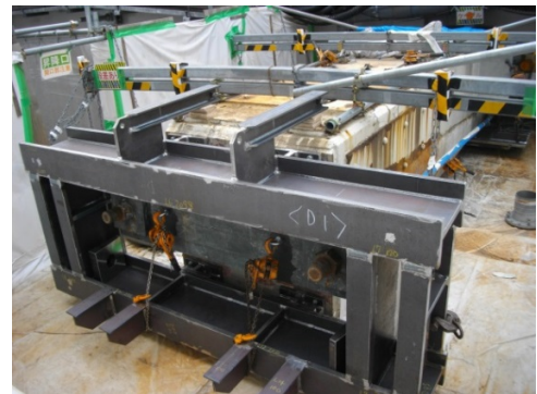
写真 4 既設定着梁と仮設定着梁
