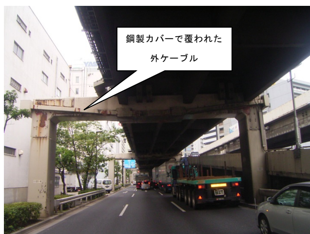
写真1 横梁補強外ケーブルの設置状況
