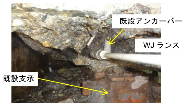
写真 1 WJ 削孔による支承撤去
