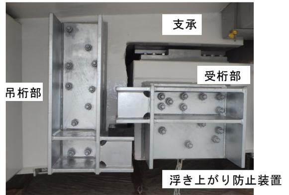
写真4 支承取替え完了
