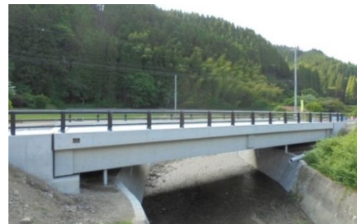
写真2 橋梁完成状況
