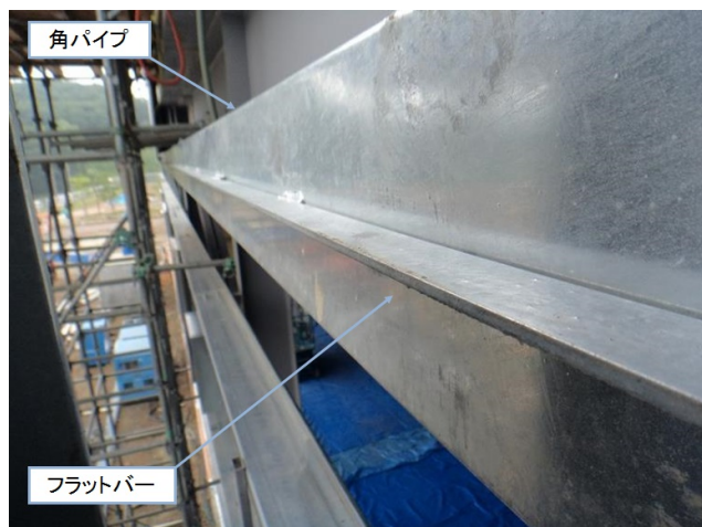
図 4 改善後の中間水切施工状況（角型鋼管）
