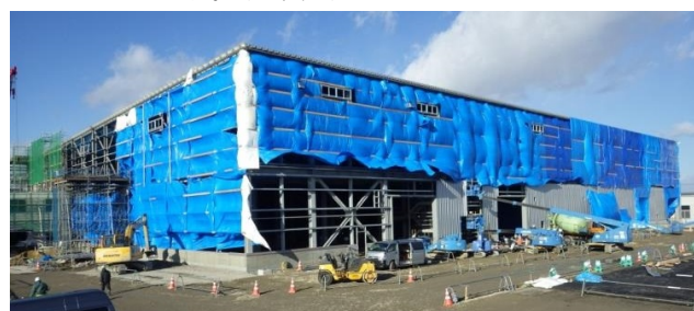
写真 1 採暖養生施工状況写真
