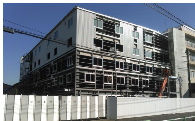
写真 2 多層階施工状況写真
