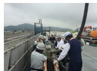
写真 7 コンクリート打設
