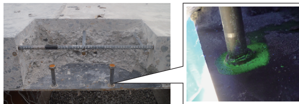
写真 4 スタッド溶接部の磁粉探傷試験 (試験体-②)
