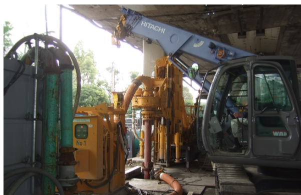
写真8 TBH工法での施工状況
