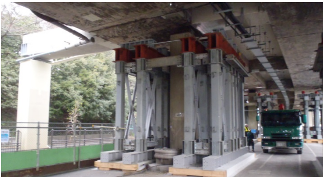
写真5 仮受けベントの設置状況
