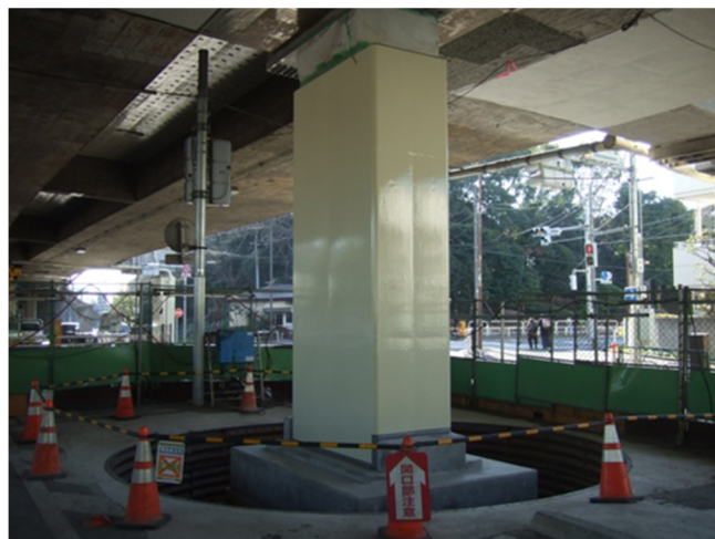
写真7 橋脚補強施工完了写真
