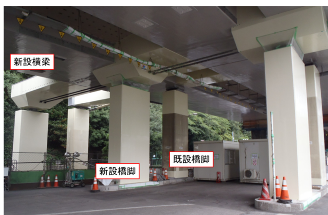
写真2 新設横梁・新設下部工 完成写真
