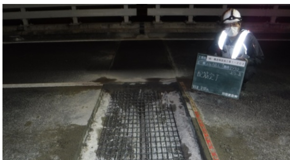
写真4 床版連結工施工状況
