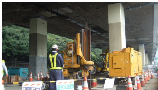
写真9 サイレントパイラーでの施工状況
