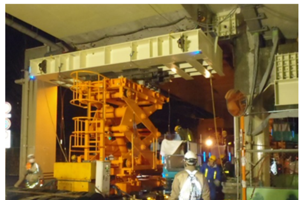
写真6 大型ブラケットのリフター架設状況
