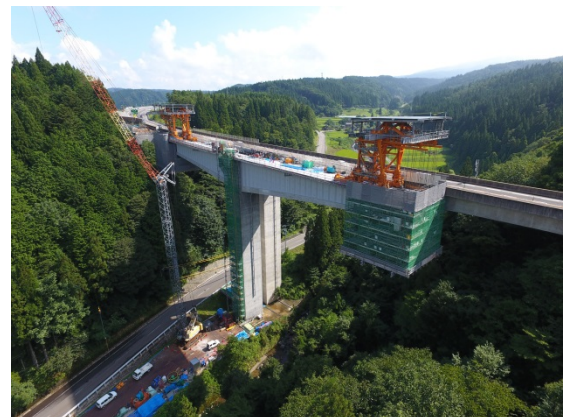
写真 1 張出し施工中の状況
