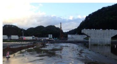
台風10号の被害状況
