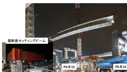
大ブロック架設状況
