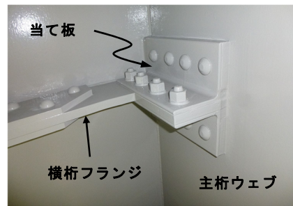
写真 2 主桁－横桁交差部当て板設置状況
