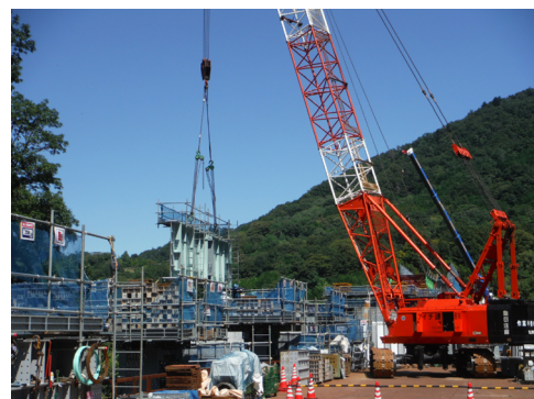
A1～P3 間 単材架設状況
