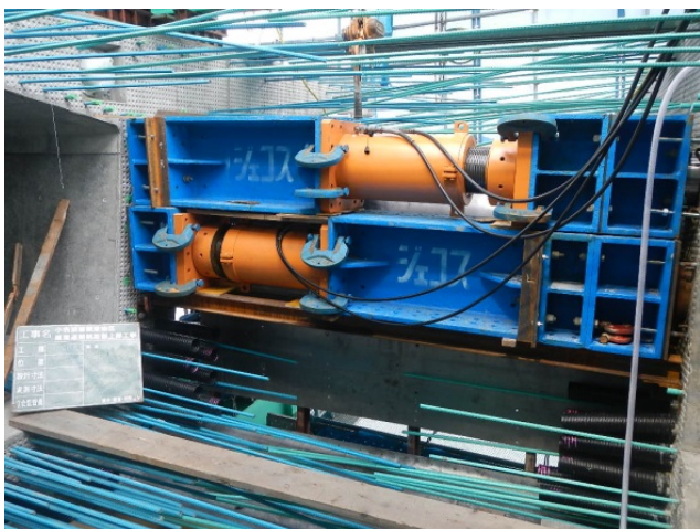
写真1 4000kN ジャッキ設置
