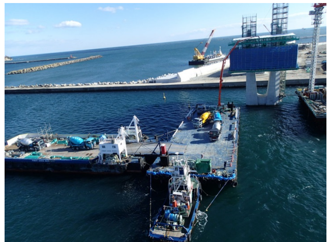
写真2 台船上からのポンプ車打設
