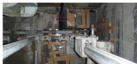
写真 1 ワイヤソー切断状況写真
