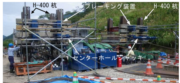
写真3 アンカー設備
