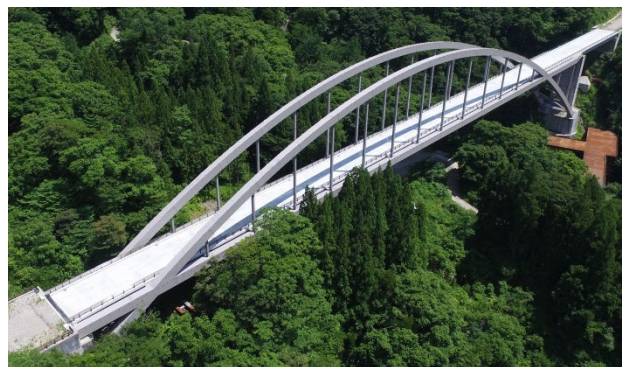
写真1 豆谷大橋全景 (A1側上空より望む)
