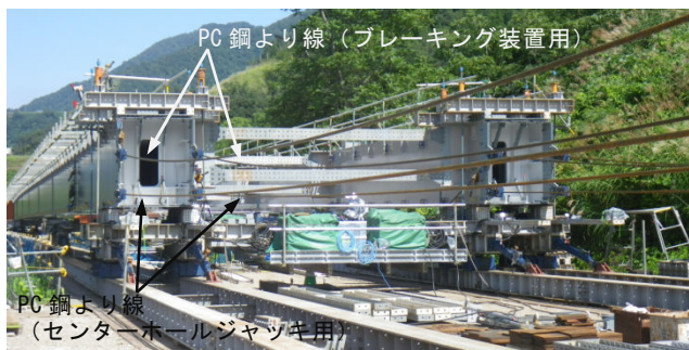
写真5 送出し時 PC 鋼より線取付け
