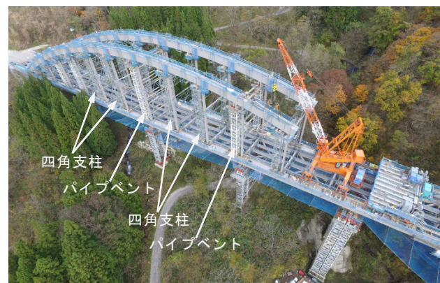
写真11 上部アーチ架設
