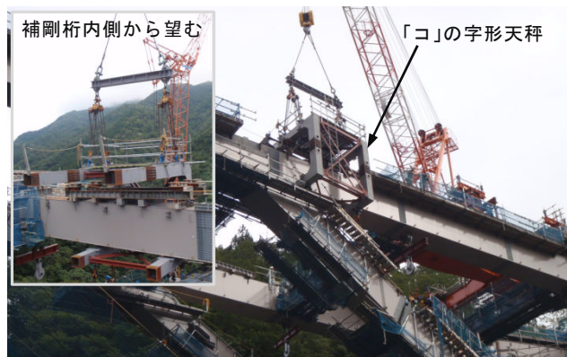
写真9 「コ」の字形天秤による架設
