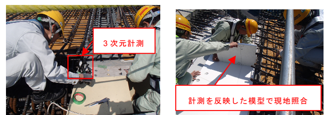
写真 10 3次元計測状況と模型の現地照合状況
