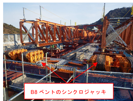
写真 5 シンクロジャッキ設置
