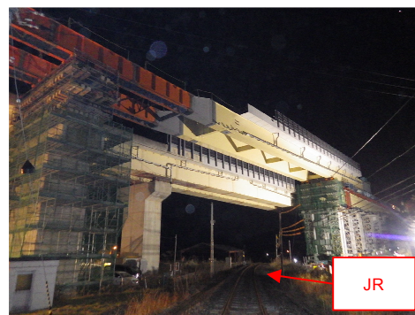
写真 4 送出し架設
