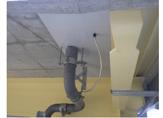
写真12 連結板下面の排水処理
