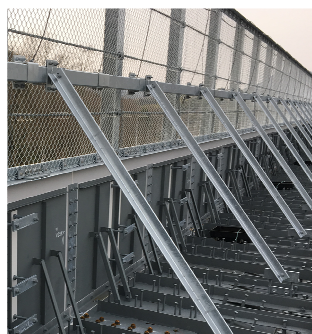
写真 2 控え材の設置状況
