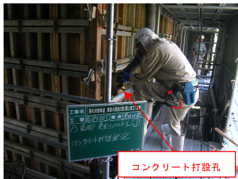
写真7 コンクリート打設孔設置
