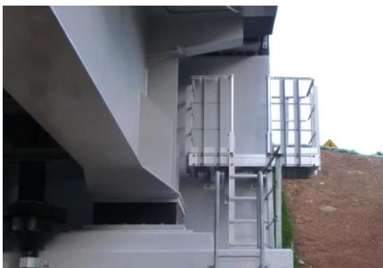
写真8 桁端部のアルミニウム合金製検査路
