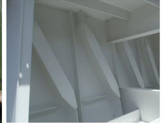
写真2 折れ線の補強リブ
