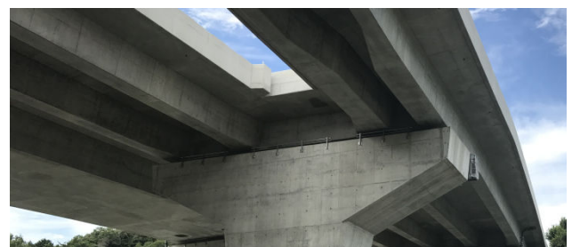
写真 1 主桁分岐部（下り線 P1）
