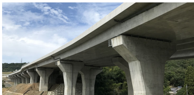
写真 3 完成写真 (上り線 A1 側面より)
