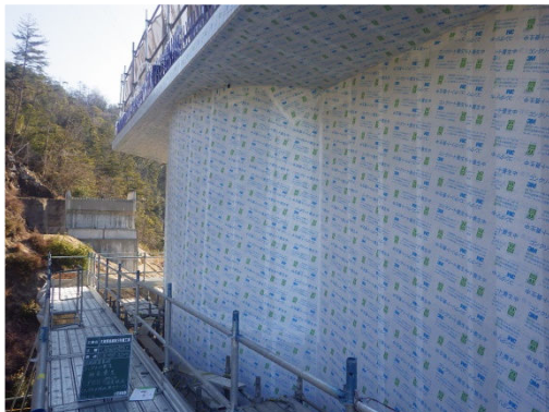
写真 8 延長養生実施状況
