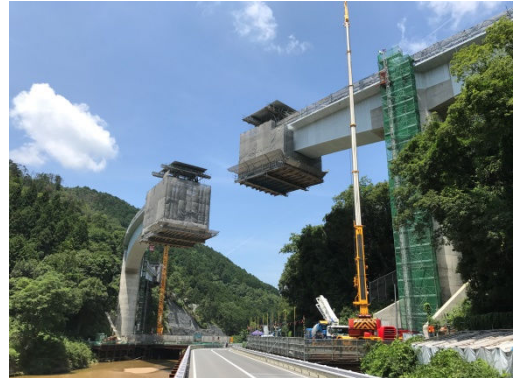
写真6 張出し架設状況
