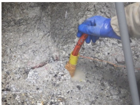
写真 2 PS 工法 (PS 爆薬装薬)
