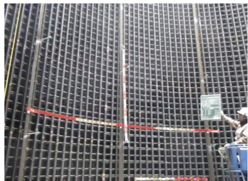
写真 3 組立用鋼材設置
