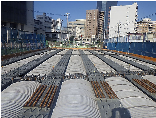
写真7 床版埋設型枠（アーチフォーム）
