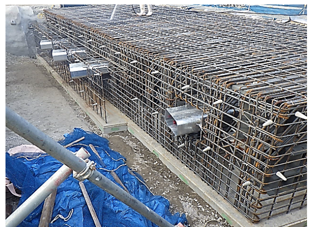
写真 5 隅角部の鉄筋・付属物配置状況
