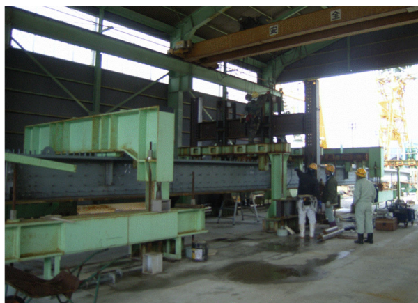
写真 2 応力導入状況
