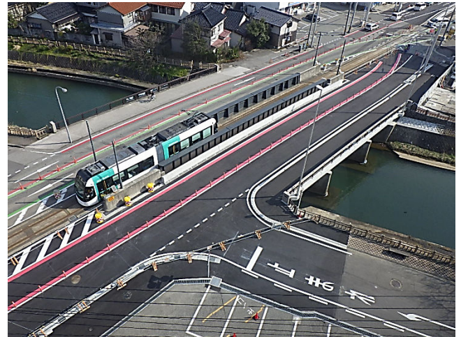
写真8 上り線完成写真
