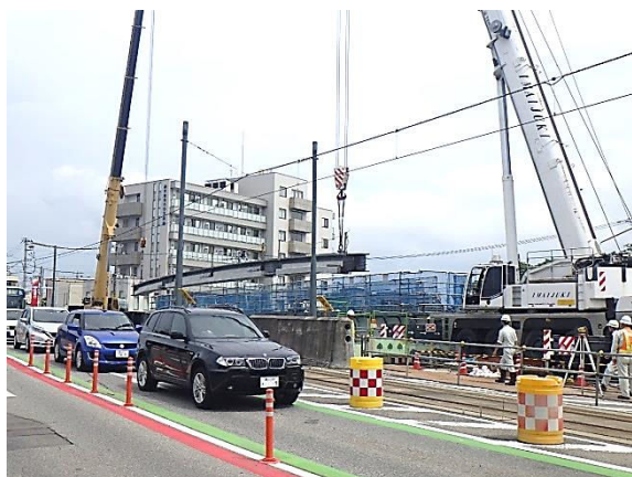
写真 3 主桁架設状況
