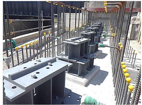
写真 4 主桁受け架台
