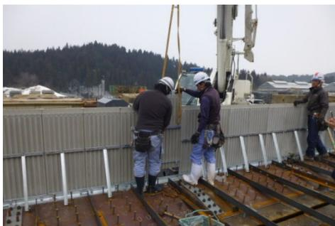
写真2 KKFの落とし込み架設
