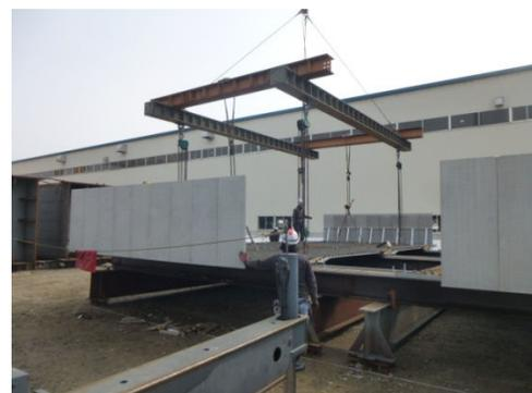
写真 1 天秤を用いた 8 点吊りの状況
