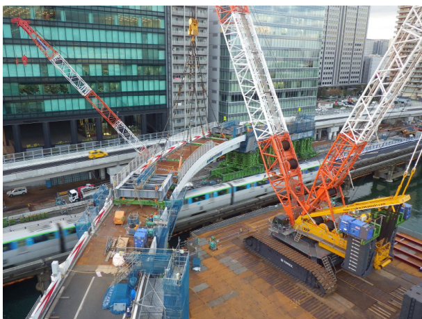
撤去直前状況
