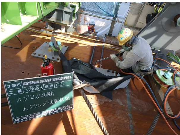
桁切断状況
