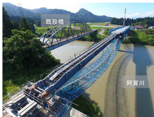
写真 1 送出し架設の状況
