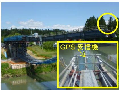
写真2 GPS 受信機設置写真
