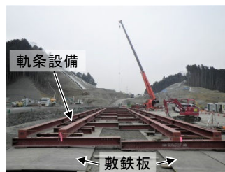
⑤-1 敷鉄板による沈下防止
