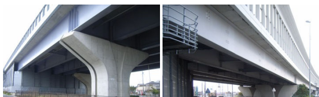
写真 1 上郷大成高架橋(左)・刈谷高架橋(右)
