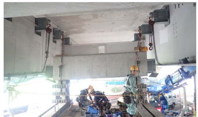
写真 4 SRC 横桁取付け状況
