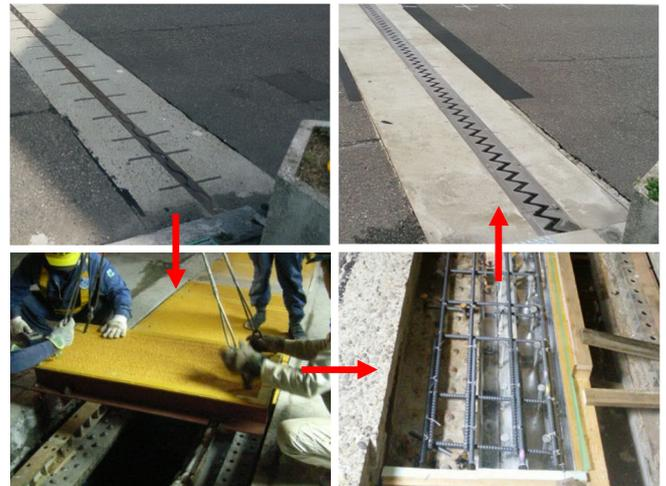
写真2-1 伸縮装置取替前(左上) 写真2-4 伸縮装置取替後(右上)
