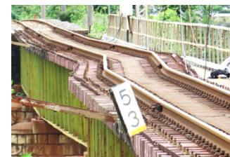
写真4 桁変位状況
