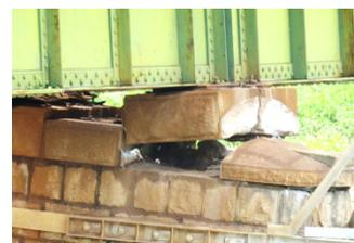
写真2 P4 橋脚支点被災状況
