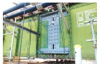
写真10 桁連結完了
