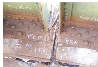
写真3 P4 橋脚支点被災状況
