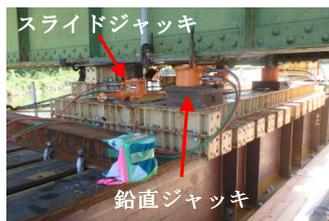
写真5 油圧ジャッキ設置状況
