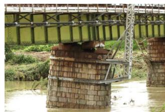
写真1 P4 橋脚傾斜状況
