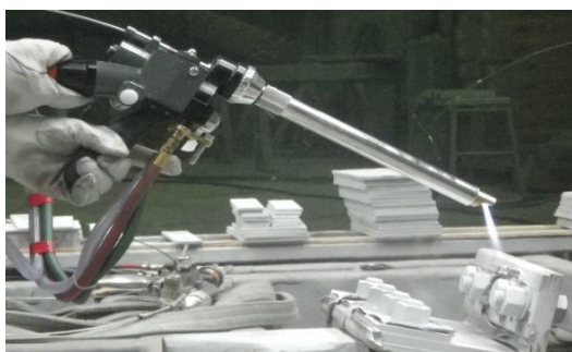
写真4 狭隘溶射ガンの施工状況
