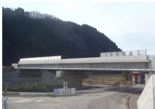
写真 1 高炉スラグ微粉末 6000 を使用した橋梁
