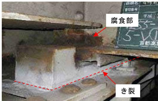
写真2 損傷状況
