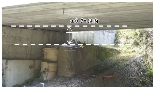
図7 舟木沢橋での上方近接制御の様子
