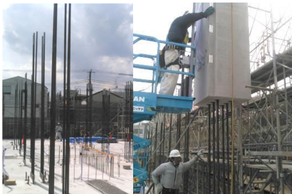
PC 鋼棒建込・PCa 柱架設
