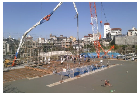
コンクリート打設状況
