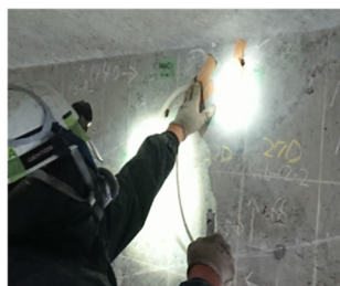
写真2 KK防錆剤の圧入
