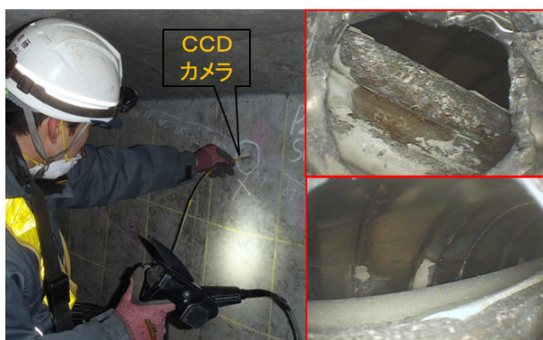
写真7 グラウト充填調査の状況
