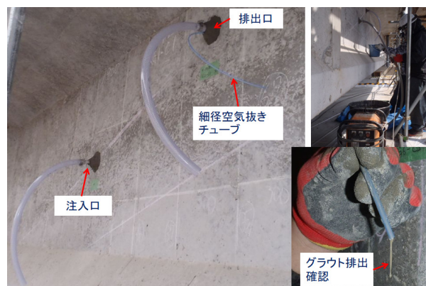
写真9 グラウト再注入の様相
