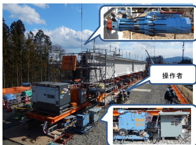
図 17 登米沢橋の緊張状況
