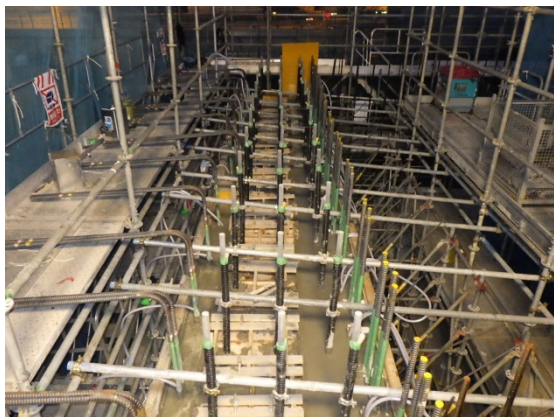
写真2 下部工後打ち施工（橋台剛結部）
