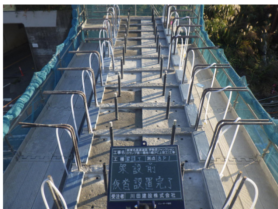
写真3 架設前仮沓設置
