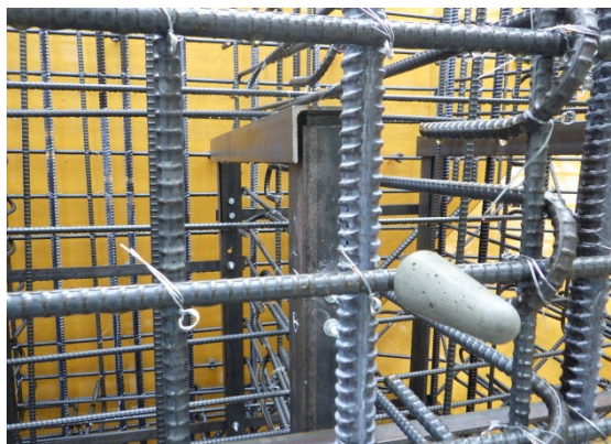
写真1 鉛直鋼棒用架台設置
