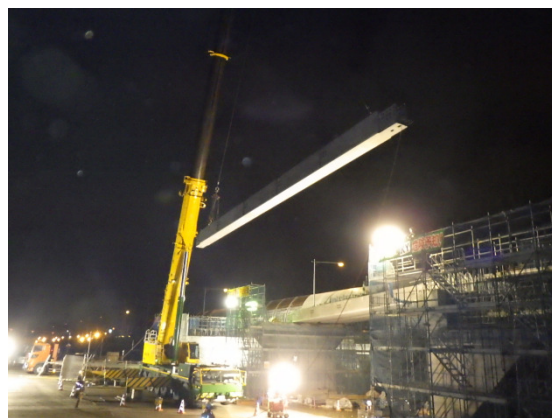
写真4 プレキャスト桁架設
