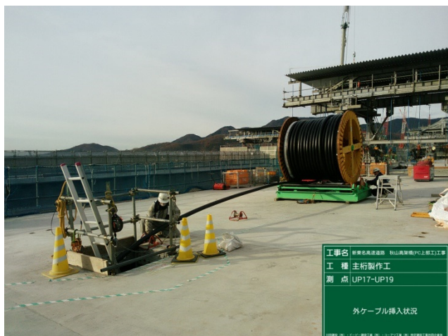
写真6 垂鉛めっきマルチケーブル挿入
