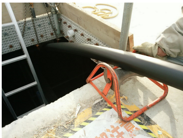
写真7 垂鉛めっきマルチケーブル挿入
