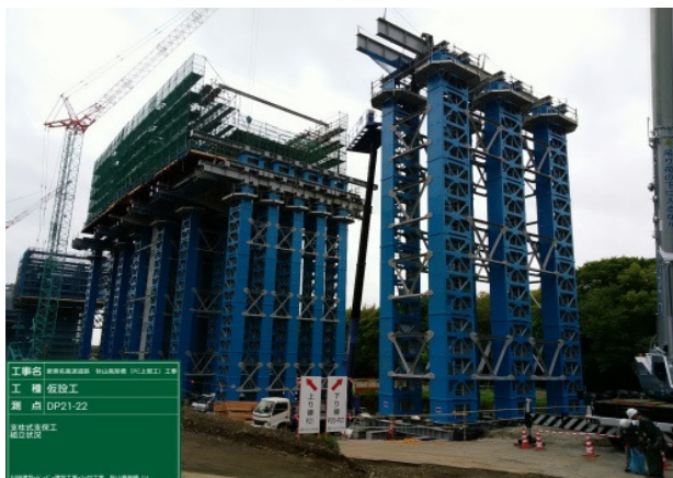
写真 1 ユニット型ベント支柱
