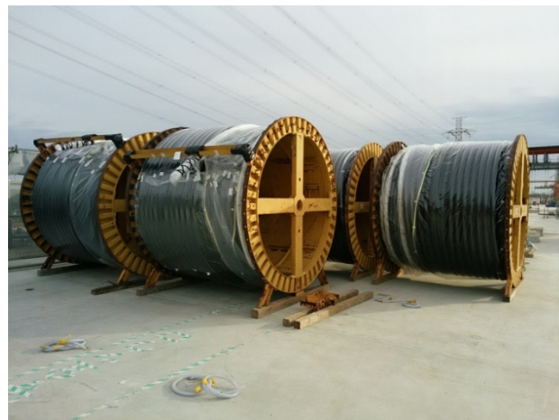
写真 5 亜鉛めっきマルチケーブル搬入
