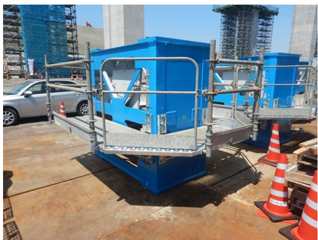
写真 3 ブラケット足場
