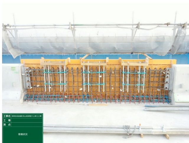
写真9 場所打ち壁高欄部
