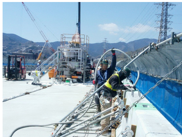
写真11 接合部モルタル注入
