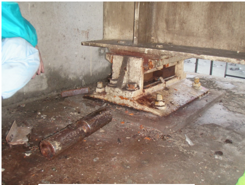
写真3 脱落したローラー
