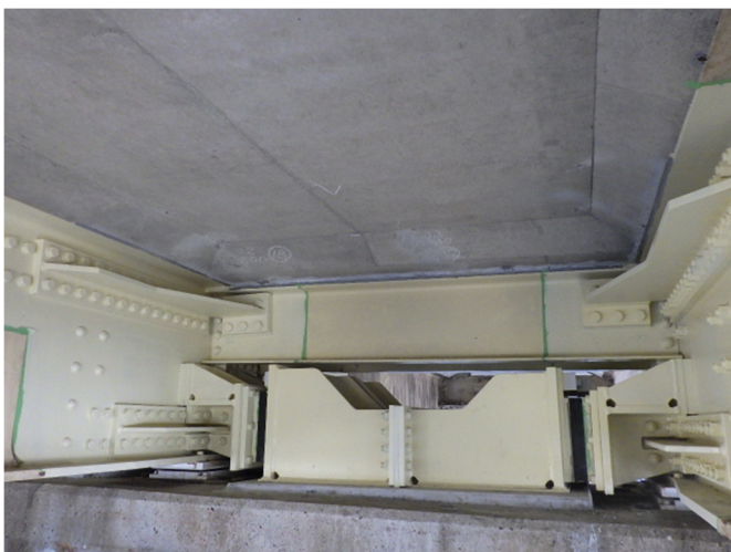
写真 6 水平支承設置状況 (P1 橋脚)
